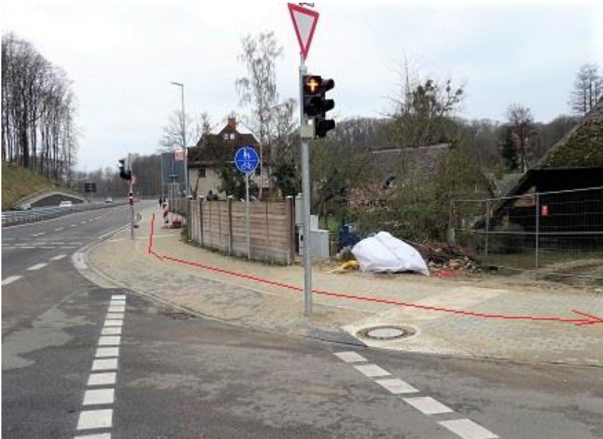
Einbiegung von B 321 in Alte Critzer Landstraße
